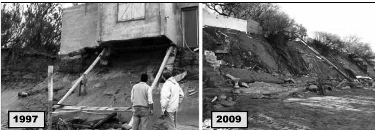
Figura 8. Deterioros producidos por la tormenta de 1997 y 2009 en la zona de Monte Hermoso. Sector frente al Faro Recalada.
