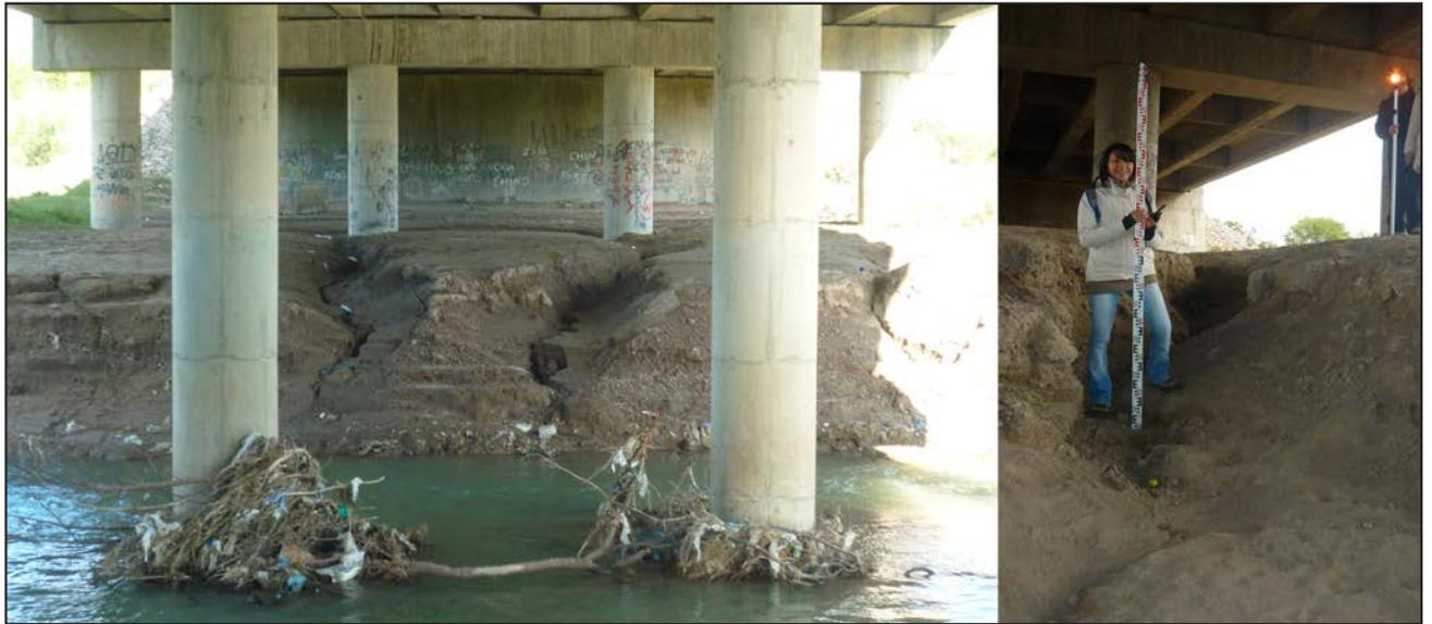
Figura 19. Cárcavas sobre margen derecha del río Arenales que afectan pilas del puente.
