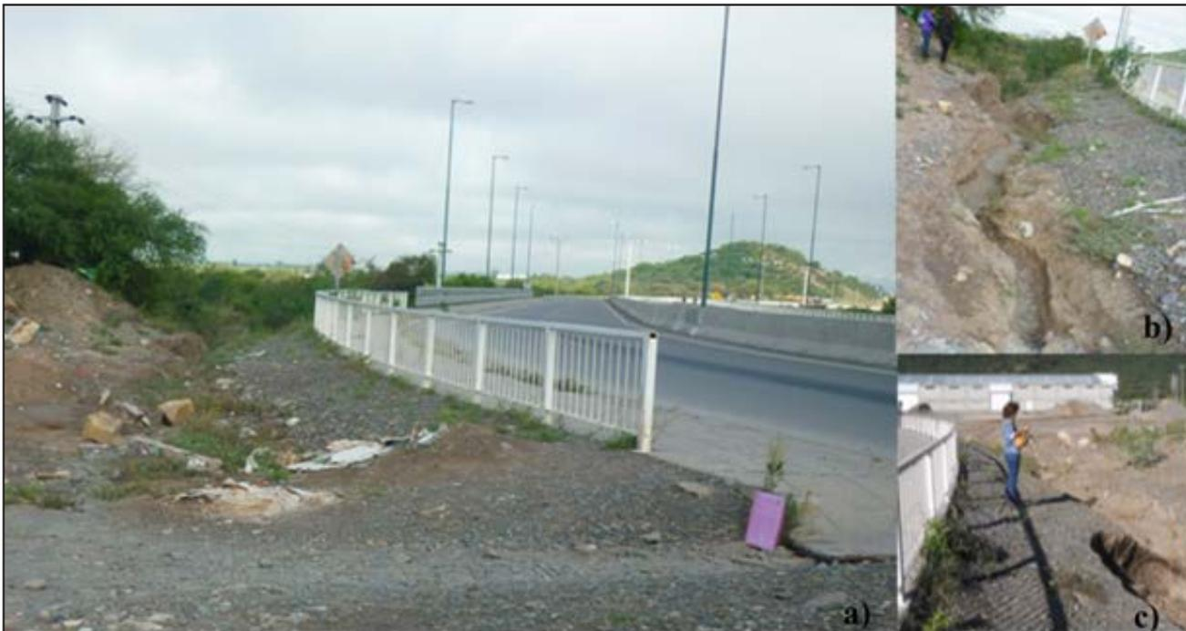
Figura 4, a, b y c. Progresión del cárcavamiento, en la margen izquierda del puente del río Arenales.
