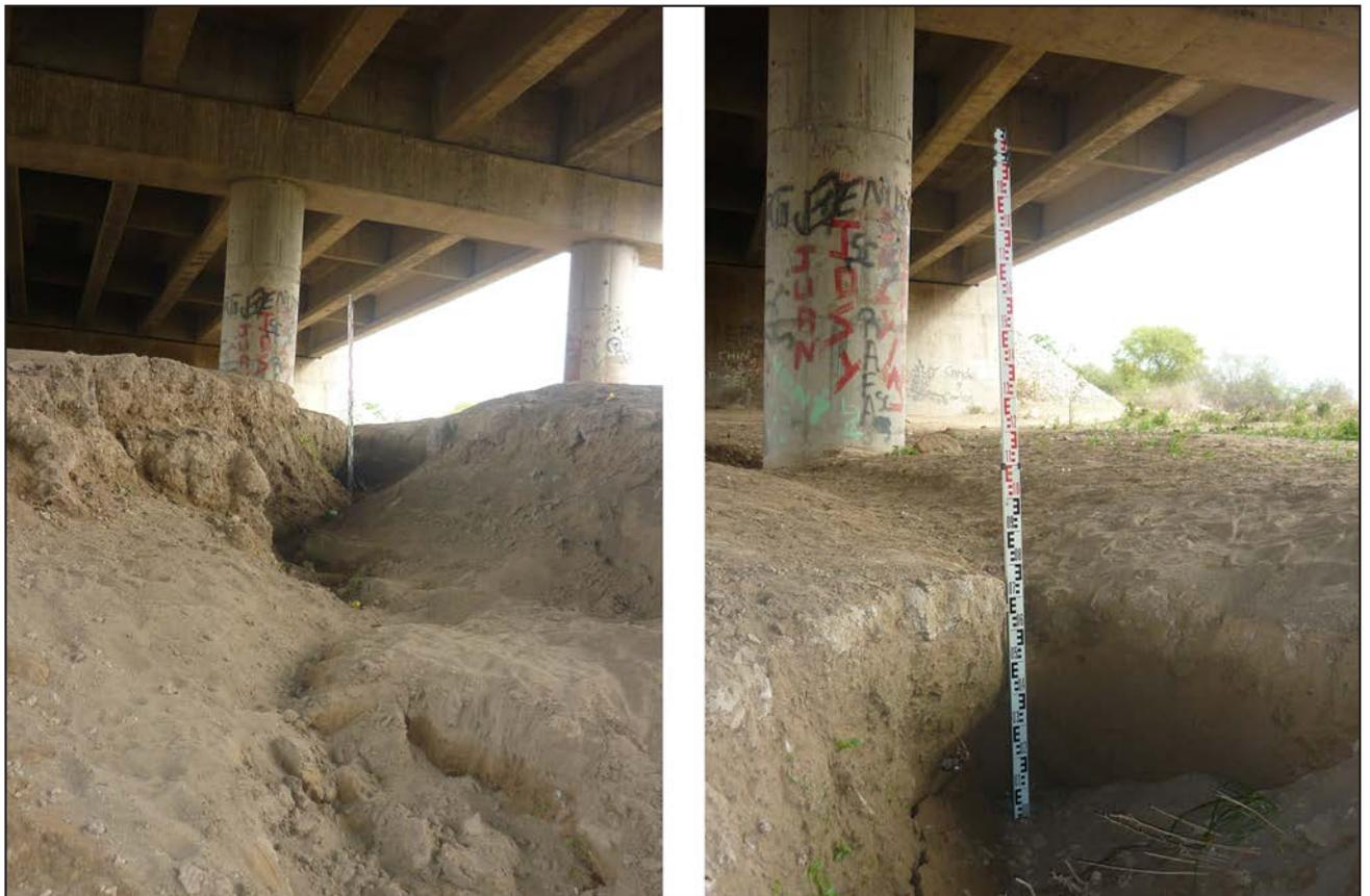
Figura 7. Surcos de erosión en la margen derecha del río Arenales.
