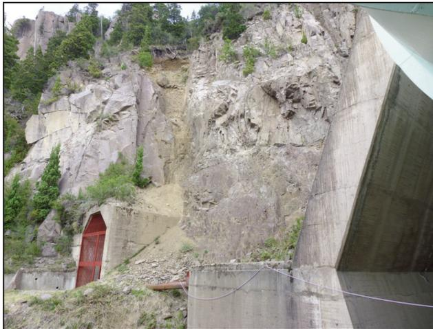
Figura 14. Detalle de la falla inferior, indicada en la Figura 13, sobre el acceso a la galería de inspección.
