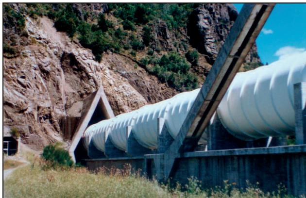
Figura 2. Boca II del túnel de aducción, protegida por “La Capilla”, y comienzo del puente tubería.
