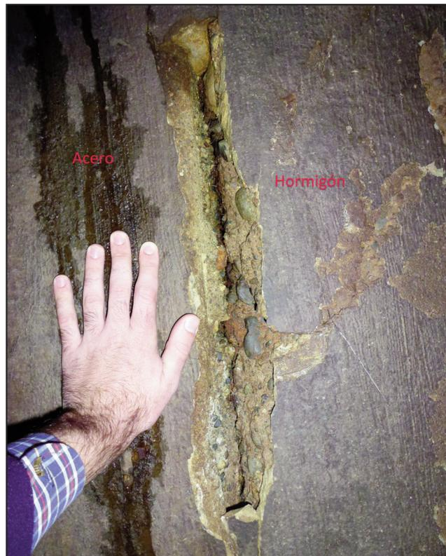
Figura 17. Detalle de la fisura localizada en el contacto hormigón - acero, en el túnel de aducción, próximo a la Boca II.
