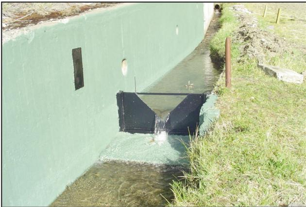
Figura 4. Detalle del Aforador 2, ubicado en el sector sur de la Capilla.
