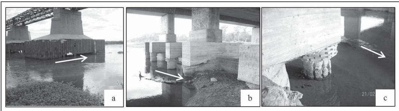
Figura 10. Socavación de pilas y cabezales. (a): Puente Ferrocarril, con procesos de corrosión de las tablestacas de protección de pilas. (b y c): Puente San Francisco Solano, observar el eje mayor de los cabezales transversales a la corriente.
