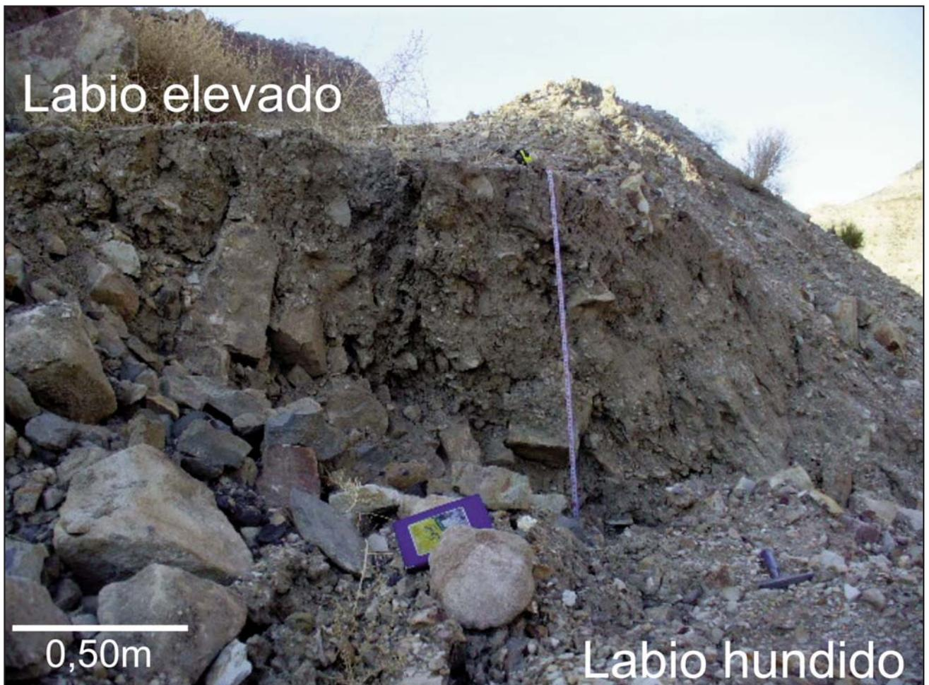
Figura 5. Vista al NNE de la berma desmembrada entre la 4ª y 5ª bajada y que fue afectada por un asentamiento vertical acumulado de 1,80 m.
