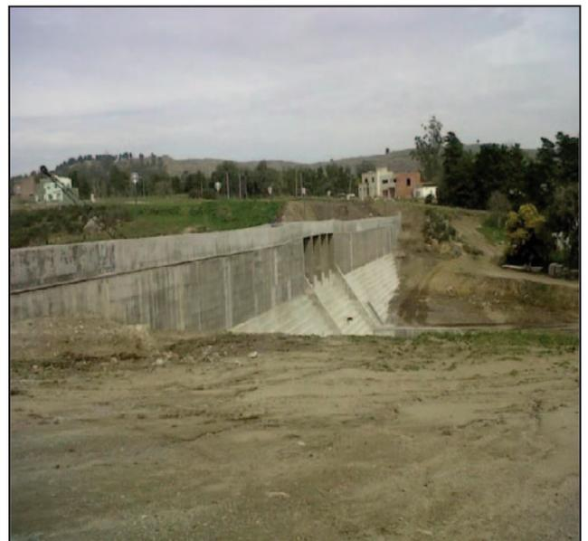
**Figura 3.** Presa del Ramal H (Tandil) - Imagen aguas abajo tomada desde adyacencias al estribo de margen derecha. Sobre el estribo de margen izquierda pueden observarse las viviendas cercanas a la presa producto del desarrollo de la urbanización.
